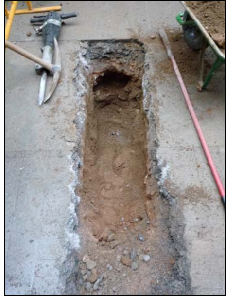
FOTO 6. Primer encreuament al Passatge del Patriarca núm. 6-10.
