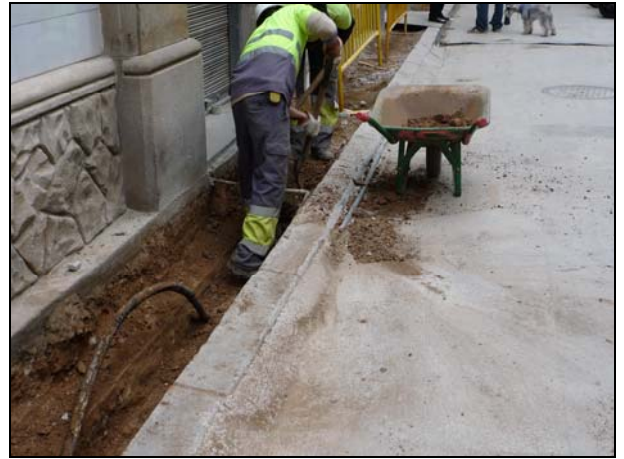
FOTO 2. Rebaixos del Passatge del Patriarca.
