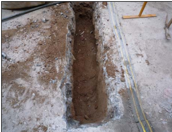
FOTO 7. Segon encreuament al Passatge del Patriarca núm. 6-10.
